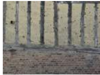
Fig. 15. Bâti à pans de bois à Grandrieu
