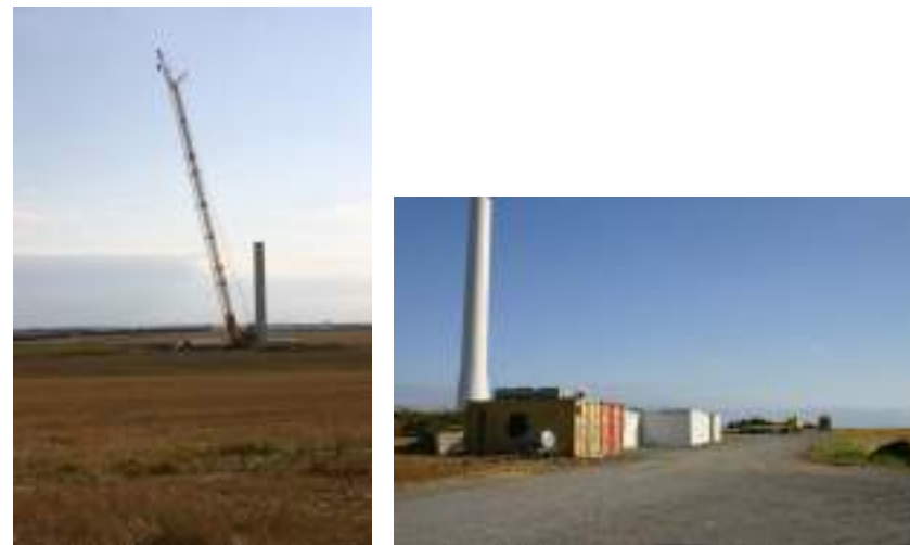
Exemples de chantier de construction d'un parc éolien
