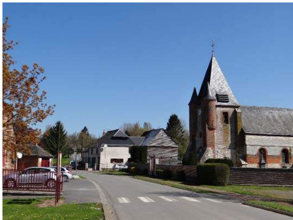
Fig. 45. Eglise de Noircourt dans le bourg (vue vers le Nord est depuis la RD18)
