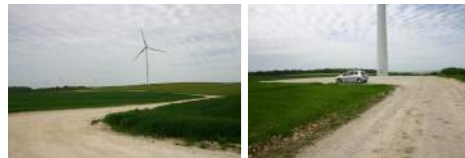
Exemples de piste d'accès et de plateforme d'un parc éolien
