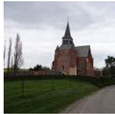
Fig. 12. Eglise fortifié de Burelles
